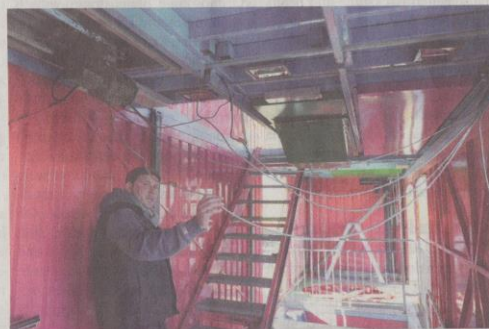
Dennis Hartmann erläutert die Arbeiten an der Elektrik.
